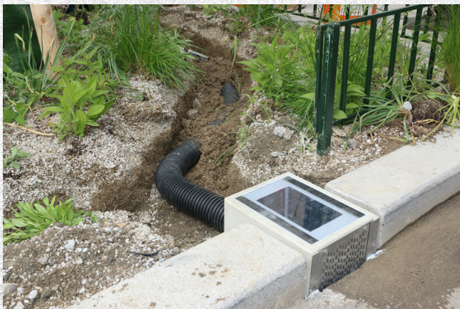
Einbau der Drainageleitung
